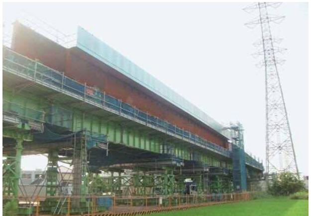
写真-3 桁組立完了
