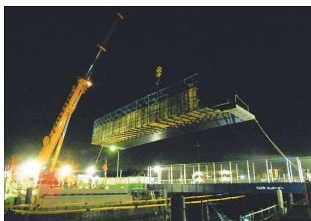
写真一9 新設桁架設状況
