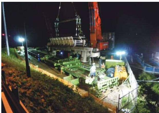
写真-11 P1～P2間桁撤去状況写真②
