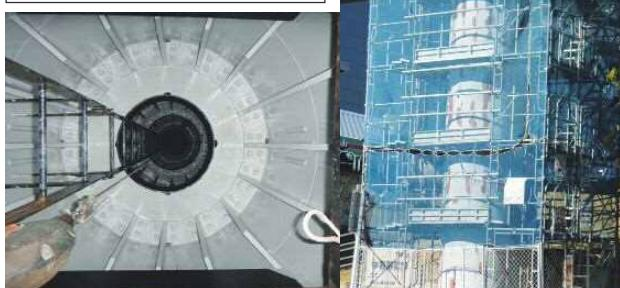
脚内現場溶接時には、熱影響による塗装剥離対応として補修塗装を行いました。
