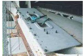
写真-33 下弦材補強後
