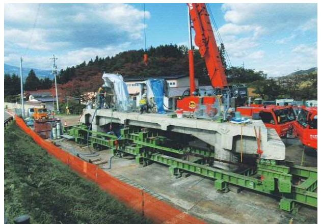
写真-13 撤去桁切断状況写真
