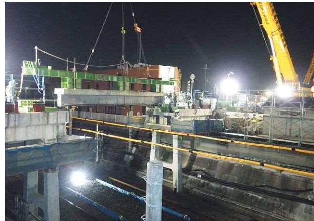
写真-5 既設橋中央径間撤去状況
