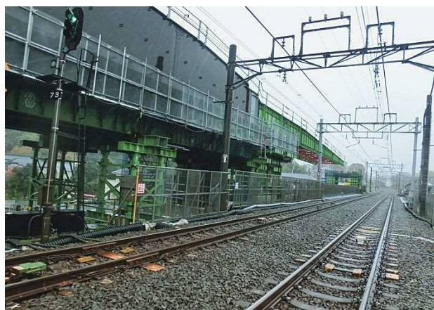
写真一八 下り線桁送り出し出し状況
