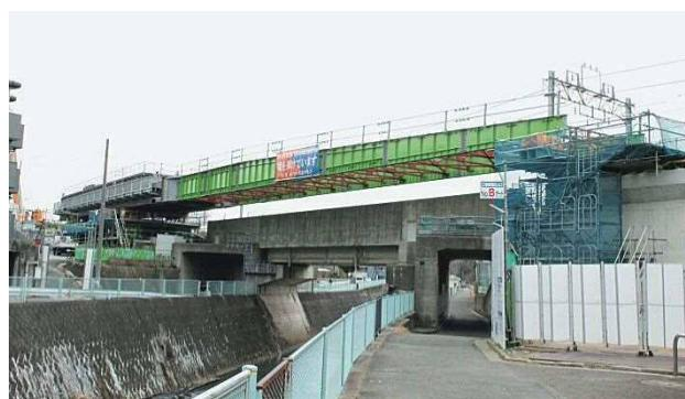
写真-4 上り線桁第7回送り出し状況
