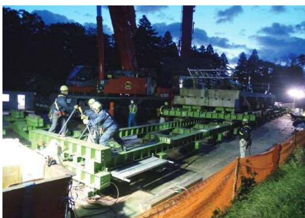
写真-12 桁縦取り状況写真
