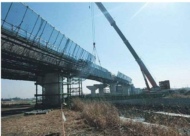
写真-7 Dランプ橋架設状況
