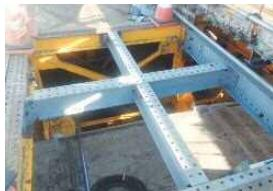
写真-19 横桁、縦桁取替え
