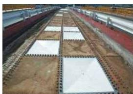
写真-5 バックルプレート取替
