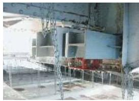
写真-31 変位制限装置設置
