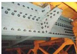
写真-24 主桁取替え後
