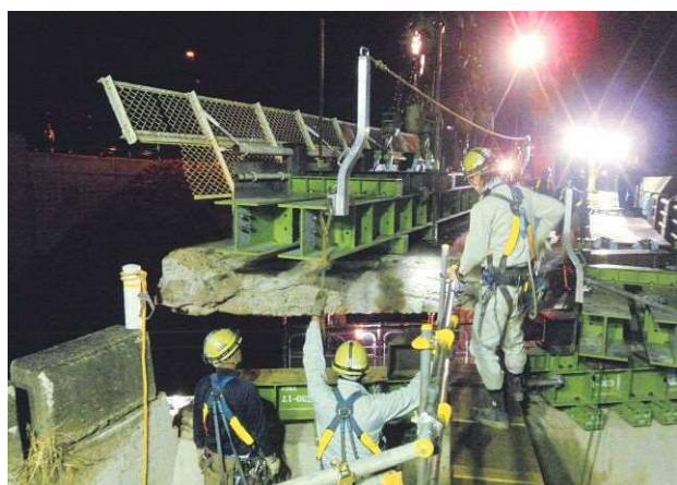
写真-8 A1～P1桁撤去況写真
