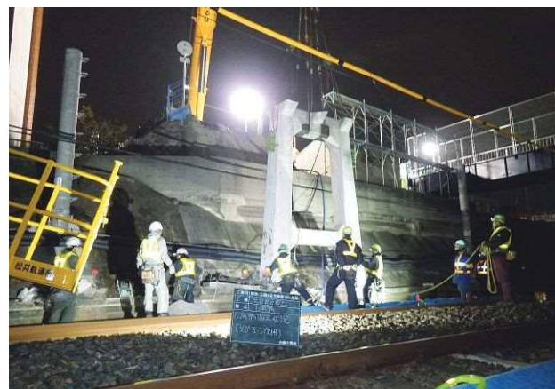
写真-6 既設橋脚撤去状況
