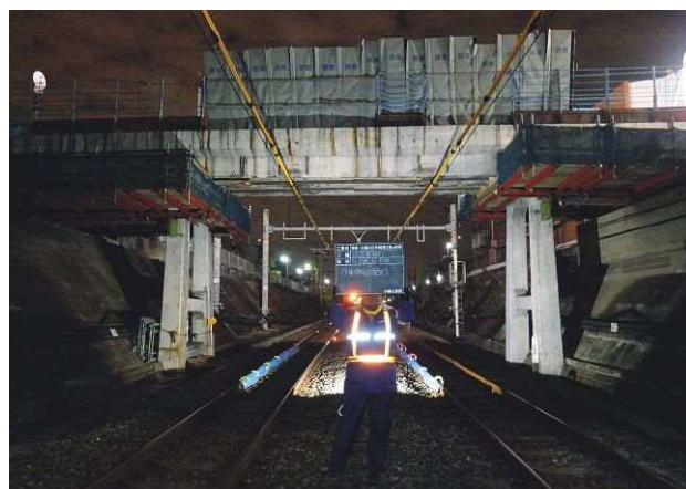
写真一7 既設桁側径間作業構台足場
