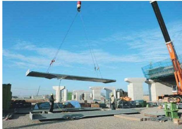
写真-8 合成床版架設状況
