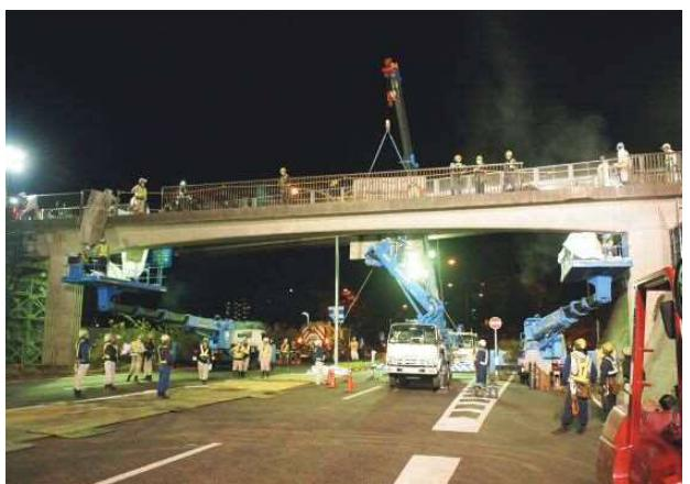
写真-7 ユニットキャリア据付前作業
