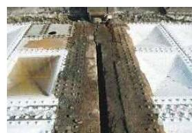
写真-9 桁端部コンクリート撤去前
