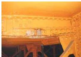
写真-21 横桁取替え前
