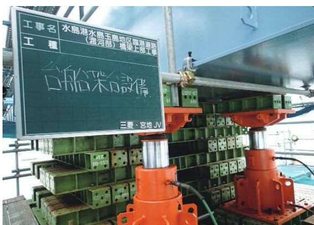
写真一5 台船架台設備（200t-400STジャッキ）
