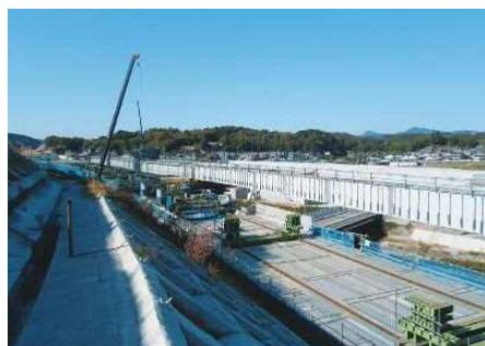
写真-3 上り線横取り架設
