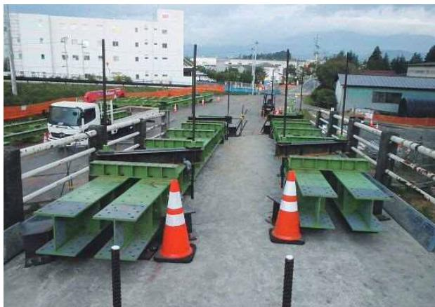
写真-6 吊り梁設置完了写真
