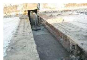
写真-10 桁端部のコンクリート撤去後
