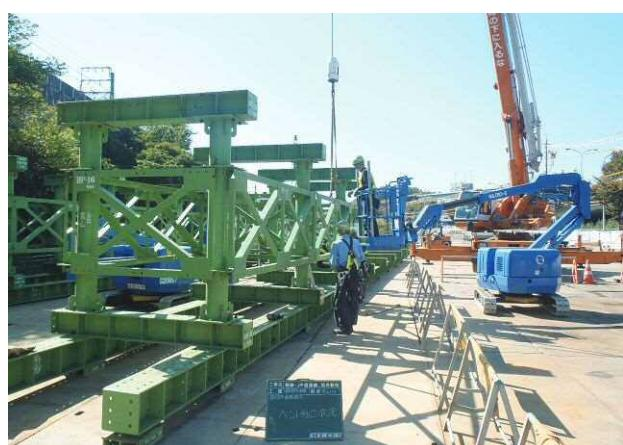
写真-1 切断桁仮受けベント組立
