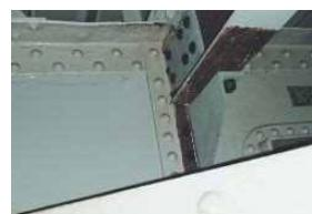
写真-36 中縦桁腹板補強
