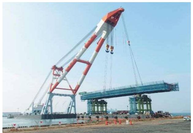
写真-3 2000t吊FC「金剛」による浜出し
