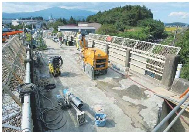
写真-2 A1～P1桁切斷状況写真
