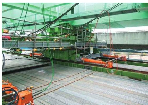
写真-9 水平ジャッキによる送出し
