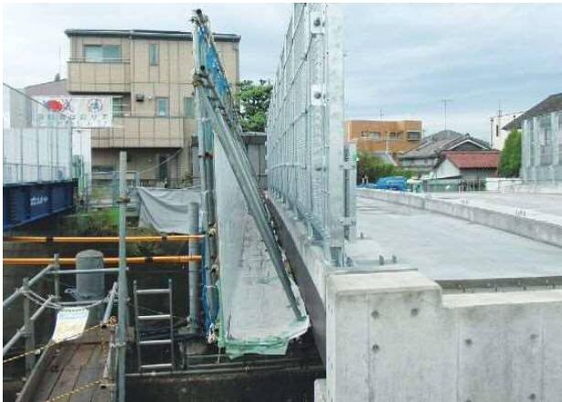
写真-10 新設桁側部足場
