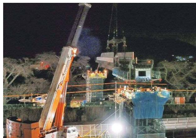
写真-3 東北本線上桁架設状況
