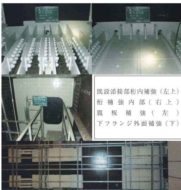
写真-4 桁内部+外部桁及び梁補強
