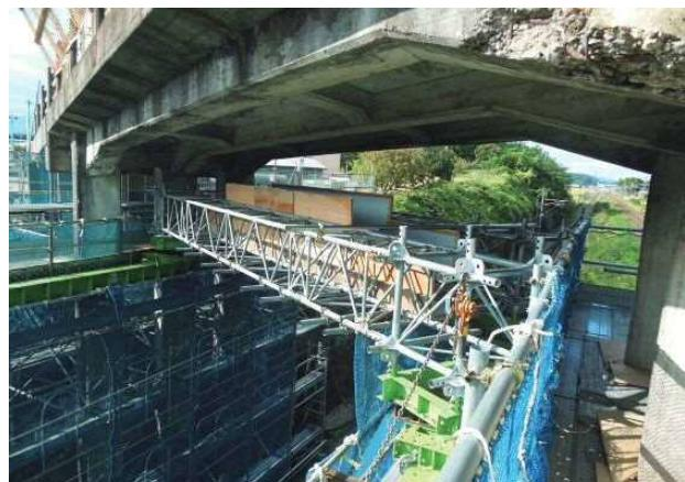
写真-4 P1～P2間防護工設置状況写真
