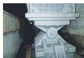
写真-46 素地調整完了
