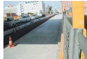
写真-8 床版コンクリート打設完了
