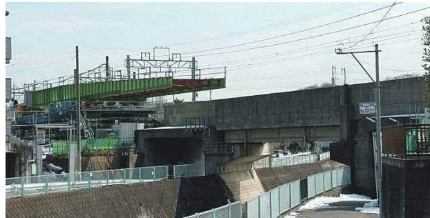
写真-2 上り線桁第1回送り出し状況
