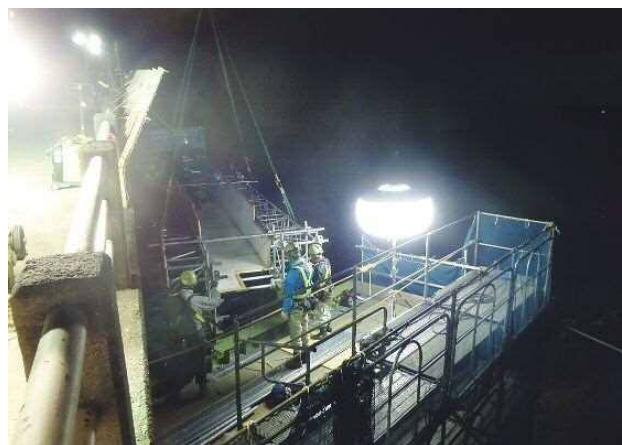
写真-3 P1～P2間防護工架設状況写真
