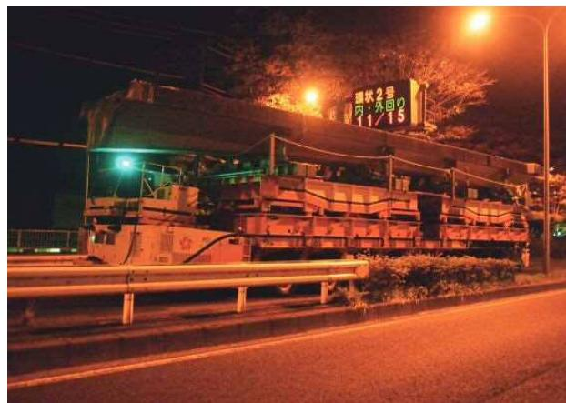
写真一12 撤去杭搬出
