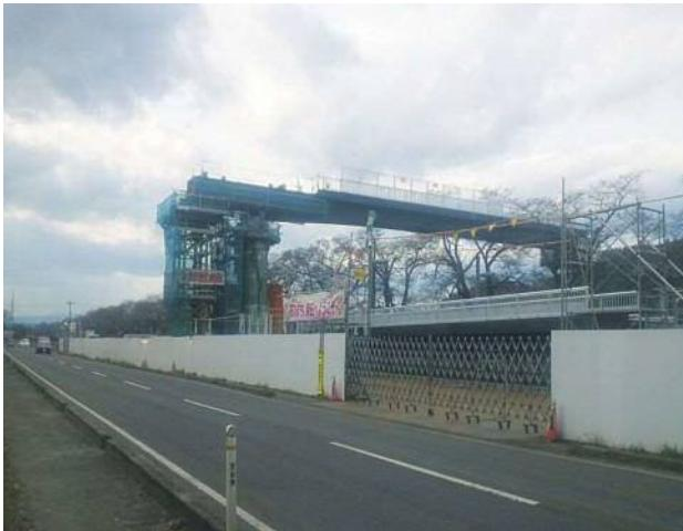
写真-4 東北本線上桁架設完了状況
