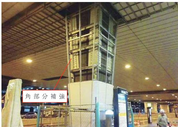
写真-3 補強完了写真（P1～P12各2脚 合計24本）
