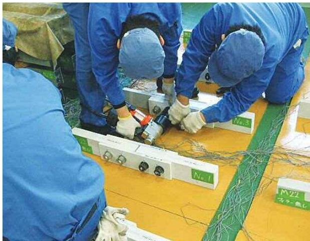
図-5 ボルト締付けの様子
