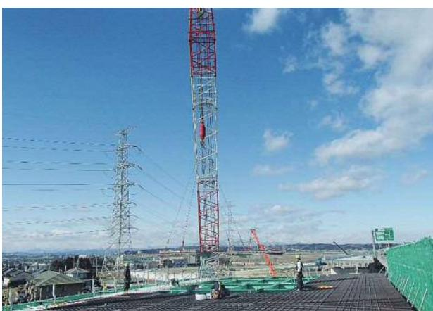
写真-5 グレーチング床版架設状況
