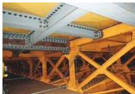
写真-22 横桁、縦桁取替え後
