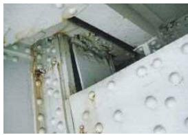
写真-26 ゲルバー部損傷個所
