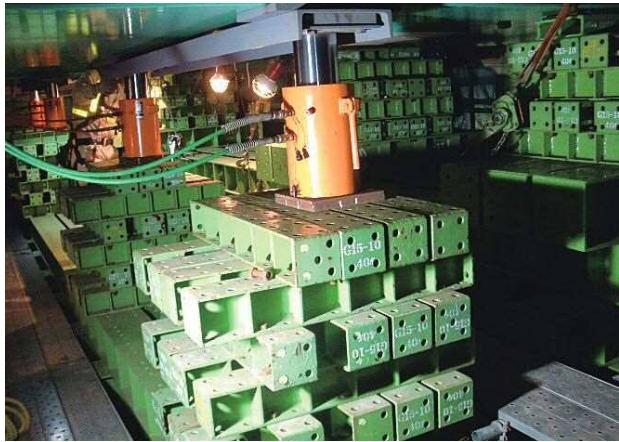
写真-14 桁降下状況
