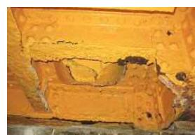
写真-11 排水栓付近腐食状況
