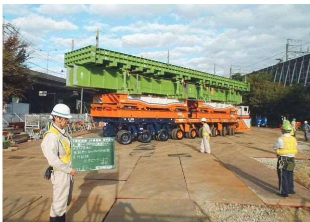
写真-5 ユニットキャリア旋回試験
