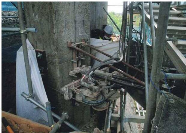
写真-15 橋脚切断状況写真
