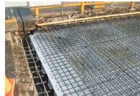
写真-7 新設床版の配筋
