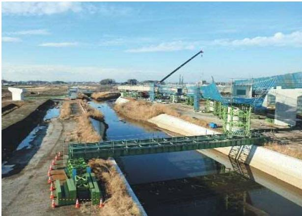
写真-6 工事桁基礎
