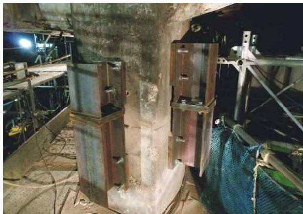
写真-9 橋脚固定金具設置完了写真
