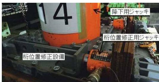
写真-7 桁位置修正設備
