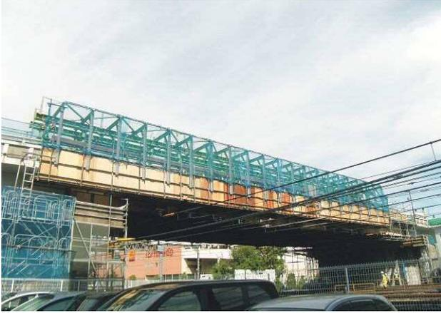
写真－12 移動式足場設置完了
