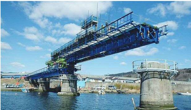
写真一6 G3桁架設状況
