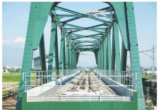
写真-13 軌道設置完了
