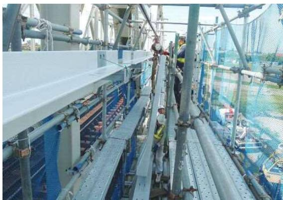
写真-17 FRP製防風柵設置
