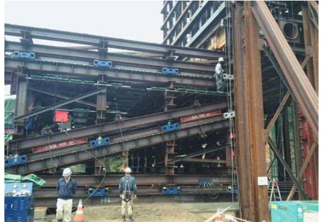
写真-12 移動架台横移動
