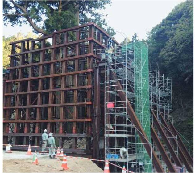
写真-30 ジャッキダウン完了
