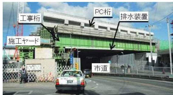
写真-5 工事桁下面排水装置設置全景
