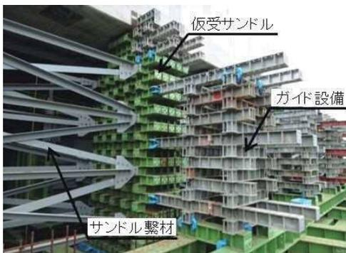
写真-8 ジャッキダウン時ガイド設備
