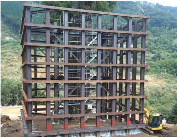
写真-3 鋼製保護枠
