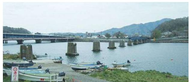
写真一 盛岡方桁流失状況
