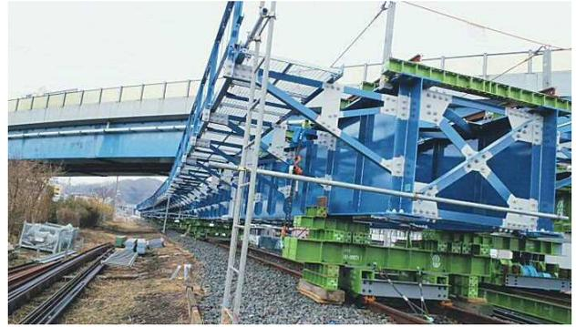
写真-3 新桁地組・仮置状況
