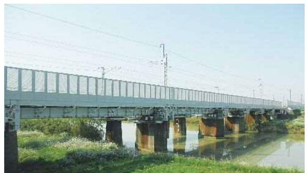
写真一8 防風柵設置完了（梯川橋梁部）
