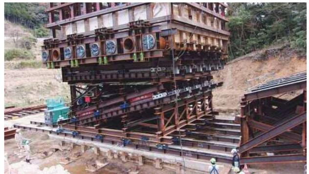
写真-14 吊り上げ用構台撤去
