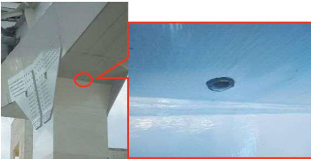
写真-13 水抜孔設置箇所
