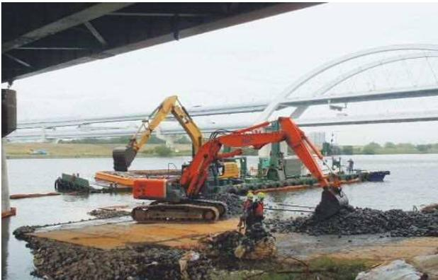
写真一八 バックホウ台船・バックホウによる搬出状況
