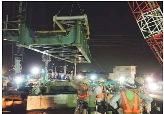
写真-22 A2工事桁撤去
