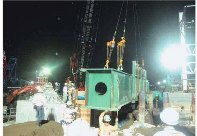
写真-21 A1受桁撤去
