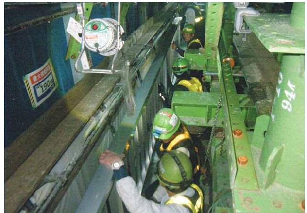
写真－16 鋼製高欄設置状況
