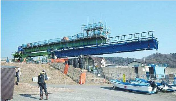
写真一4 G1桁架設状況
