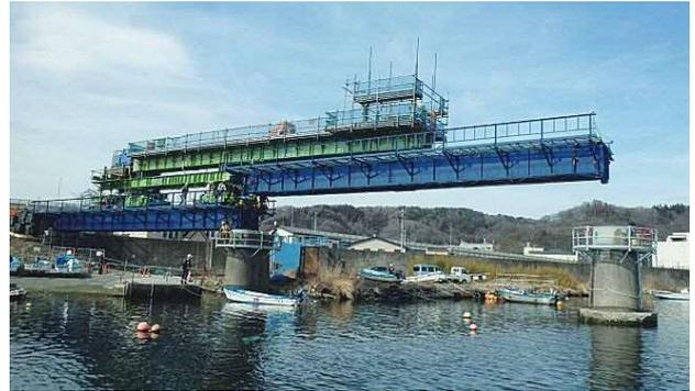
写真一5 G2桁架設状況
