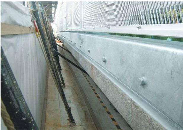
写真一八 鋼製地覆・高欄通り状況
