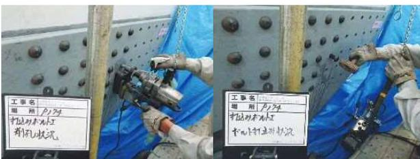
写真-3 打込みボルト施工状況
