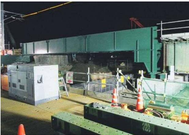
写真-4 A1工事桁架設完了
