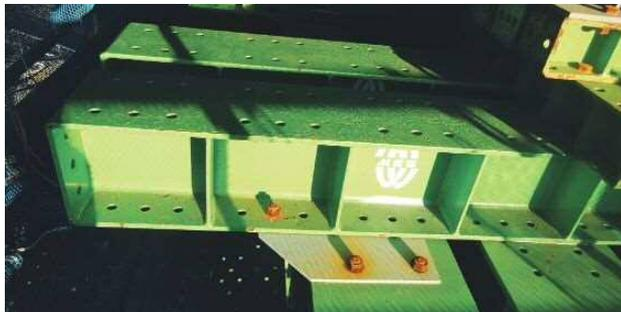
写真-6 ボルト取り付け調整プレート
