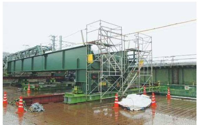
写真-2 A1工事桁地組完了
