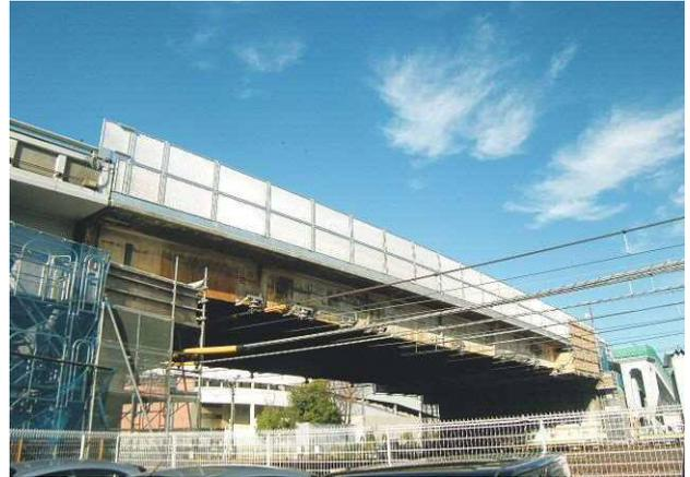
写真一二十 高欄・地覆取替え完了
