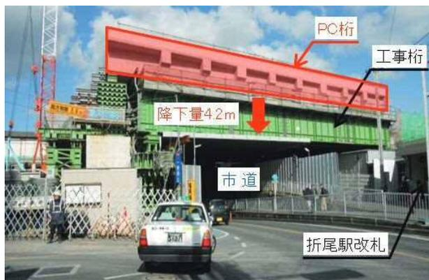
写真-1 主桁ジャッキダウン全景
