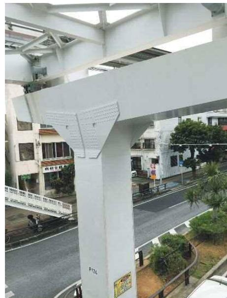
写真一15 P174橋脚（補強後）
