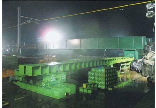
写真-6 A2工事桁架設完了
