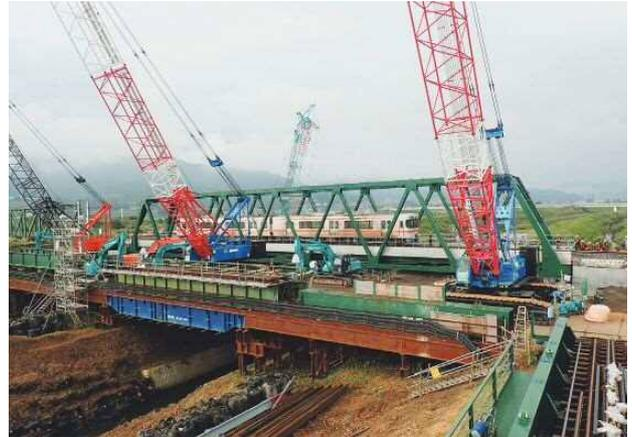
写真一26 トラス桁架設完了
