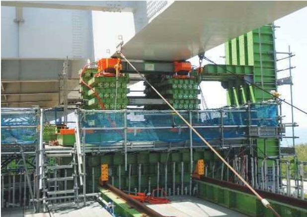
写真-5 シンクロジャッキ高さ調整
