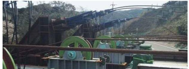
写真-20 補助ジャッキと方向転回シーブ
