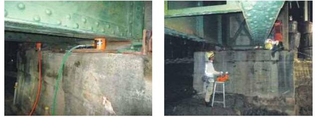
写真-16 既設桁縁切り確認
