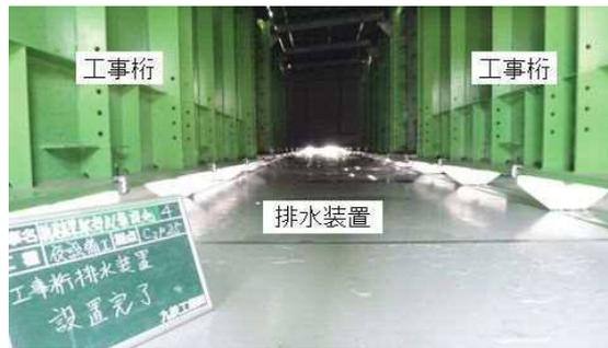
写真-4 工事桁下面排水装置設置状況
