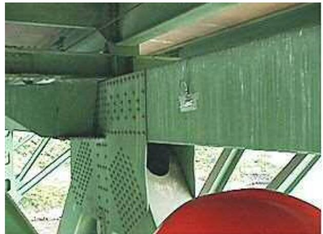
写真2 I-35Wのガセットプレートの面外変形
