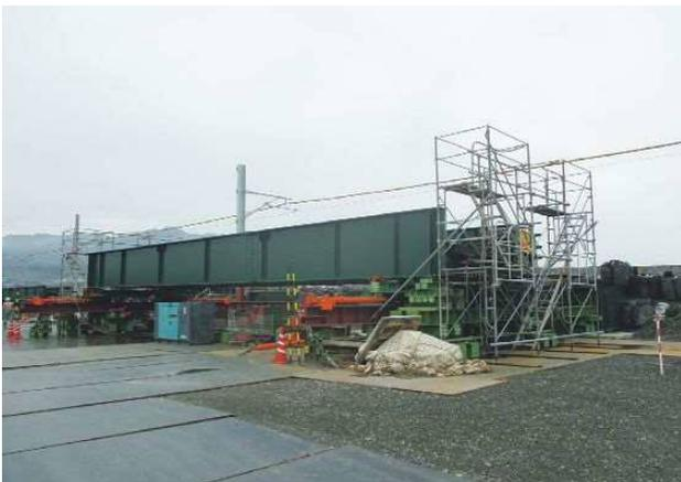
写真-5 A2工事桁地組完了
