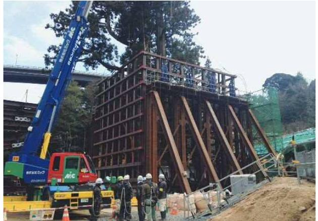
写真-6 ジャッキアップ架台（移植元）
