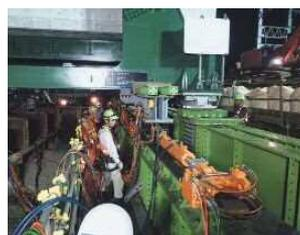
写真一25 トラス桁横取
