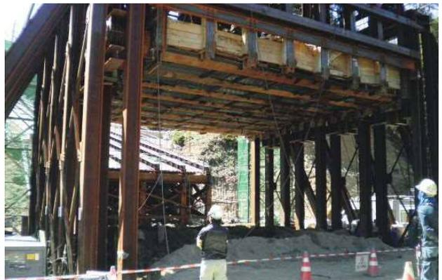
写真-9 ジャッキアップ完了（移植元）
