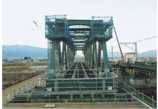
写真-11 トラス桁地組完了
