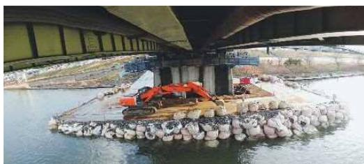
写真-4 P11橋脚 仮締切完了
