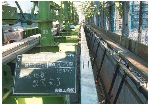
写真－15 鋼製地覆設置完了
