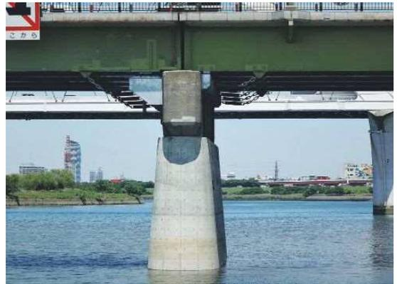
写真-1 P11橋脚 耐震補強完了
