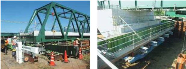
写真-14 軌条桁設置
