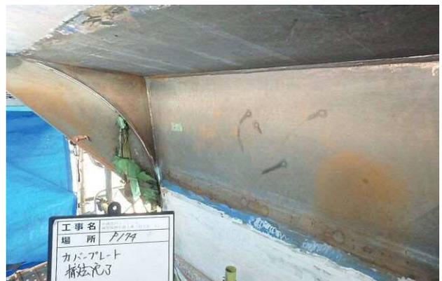
写真-9 カバープレート撤去後状況
