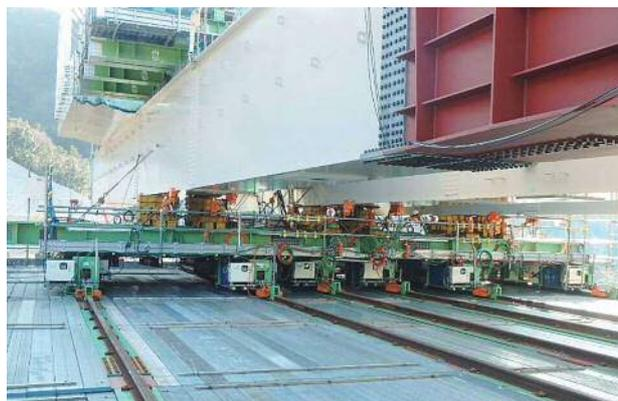
写真-9 後方台車設備
