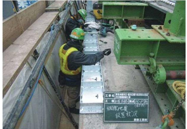
写真－14 鋼製地覆設置状況
