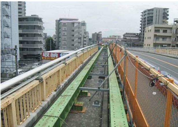
写真一4 軌条梁設置完了
