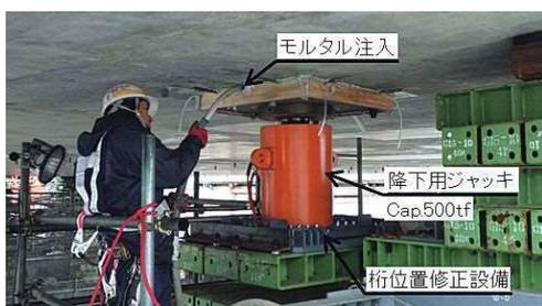
写真-6 降下用ジャッキ取付け状況
