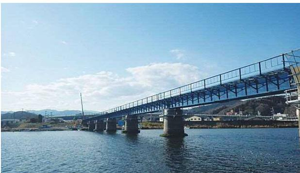
写真一8 新桁架設完了
