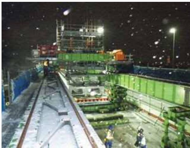
写真一9 D部補修桁架設
