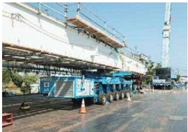
図-6 多軸台車への支持荷重の受け替え作業状況
