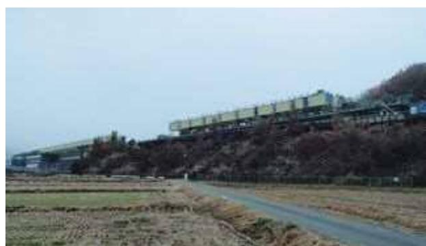
写真一4 桁組立状況 (縦送り)
