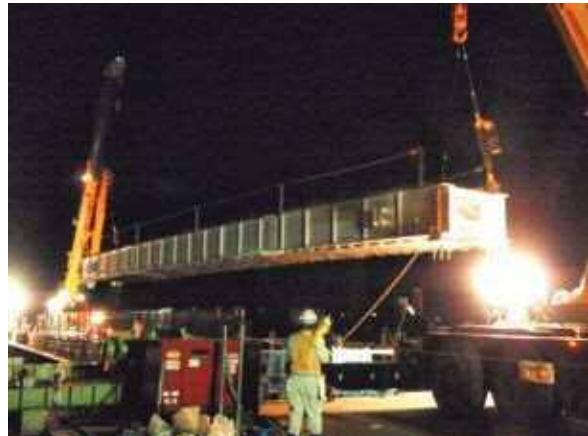
写真-1 A部新桁架設
