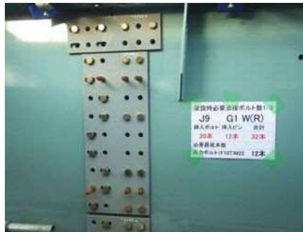
図-9 架設時必要ボルト本数明示例
