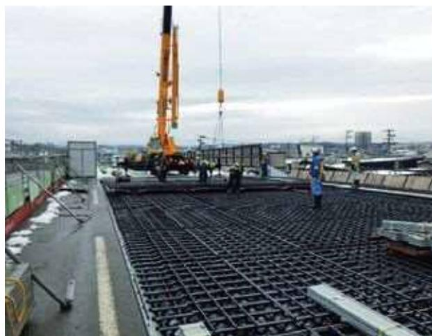
写真-4 A・B部グレーティング床版架設
