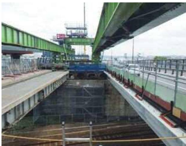
写真一7 D部既設桁撤去完了
