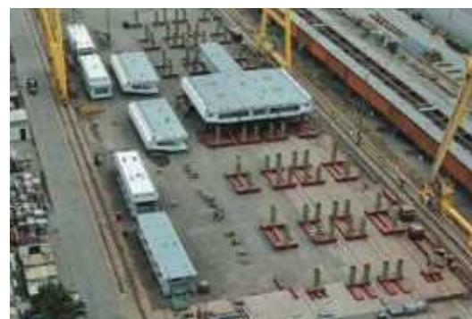
図-3 補剛桁仮組立の様子
