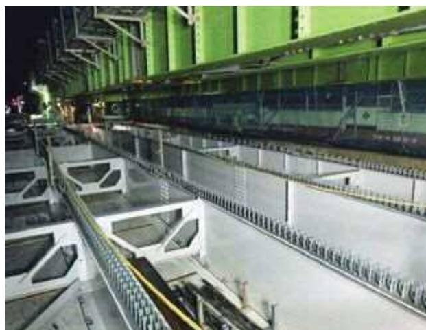
写真-3 B部新桁架設
