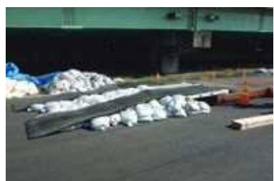
軽量土嚢によるスロープ構築
