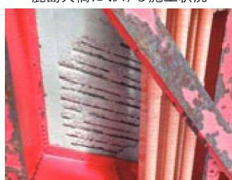
床版下面の海水による塩害損傷
