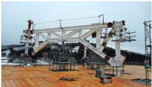
写真-2 コンコース鉄骨建方状況
