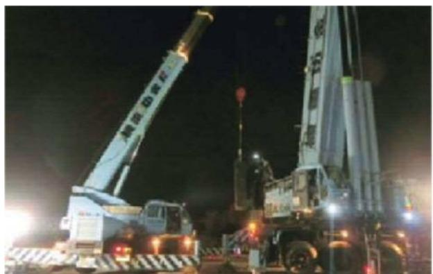
図-7 多軸台車への支持荷重の受け替え作業状況
