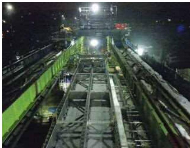
写真一11 C部新桁架設完了
