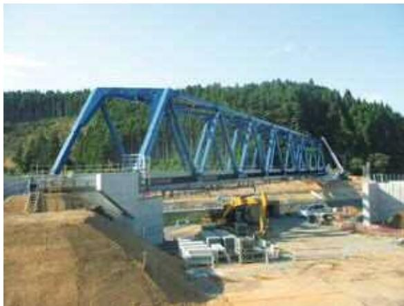
写真-12 本設桁架設完了
