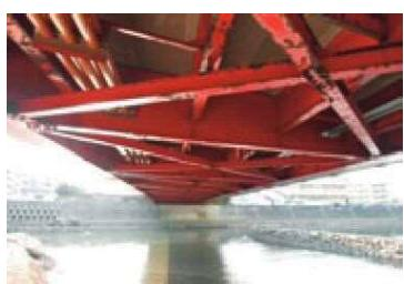
河川の消波ブロックからの海水による桁腐食
