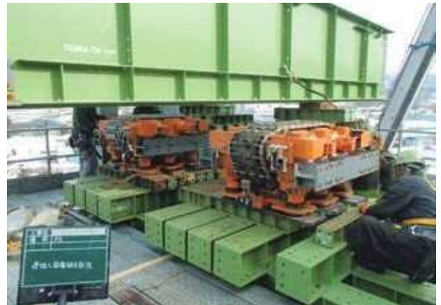
写真-8 シンクロジャッキ（駆動）
