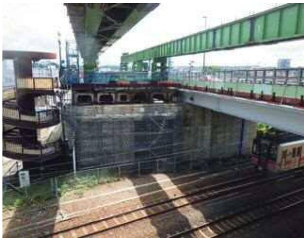
写真一8 B・C部既設桁撤去完了
