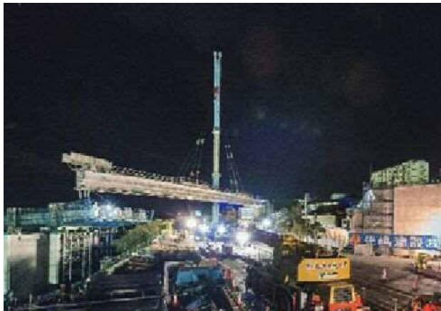
図-9 大型クレーン桁旋回状況
