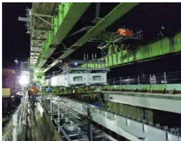
写真一10 C部新桁架設
