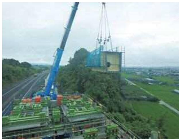
写真一3 桁組立状況 (高速道近接)
