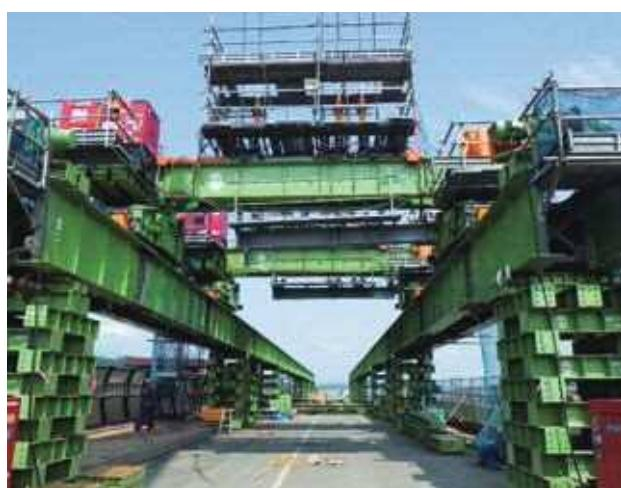
写真一5 吊り上げ台車設備
