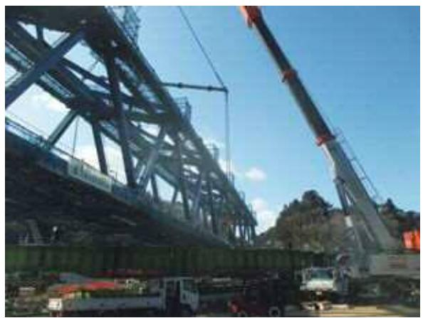
写真-9 B4ベント工事桁玉掛け状況
