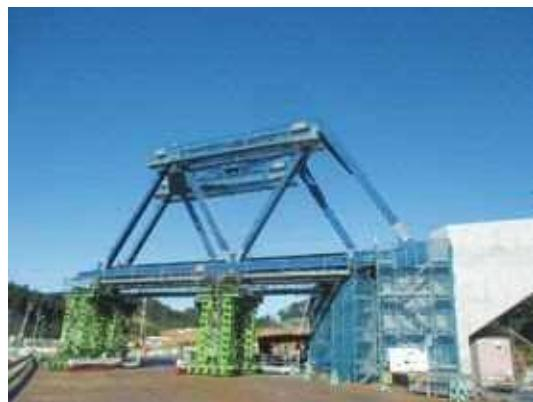
写真-3 左岸側本設桁組立完了
