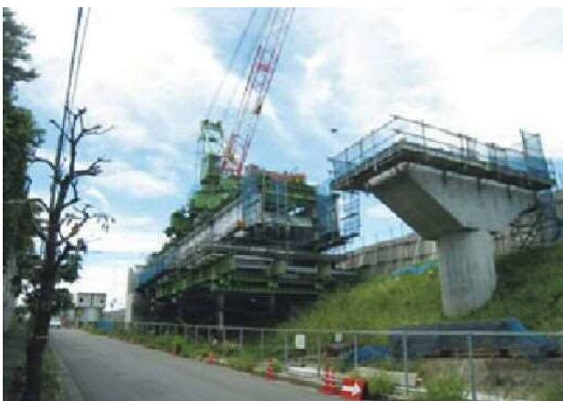
図-6 トラベラクレーンによる鋼桁架設状況
