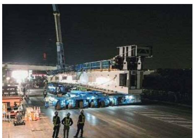
図-8 多軸台車による大ブロック架設桁運搬状況
