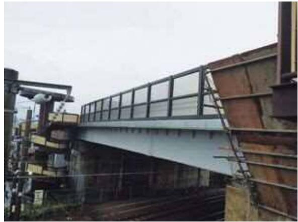
写真-13 架替完了
