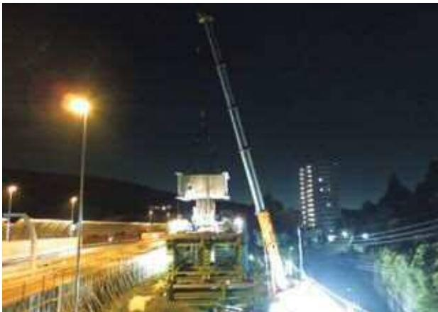
図-5 剛結部鋼製橋脚架設状況
