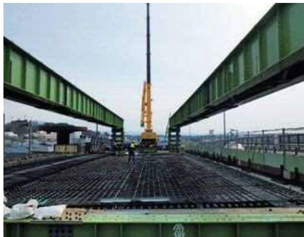
写真一12 C・D部グレーチング床版架設
