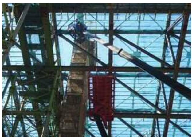
写真-16 後施工部材取付
