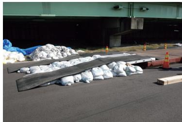
軽量土嚢によるスロープ構築
