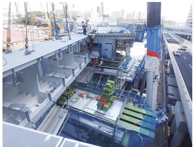
写真-18 閉合桁架設
