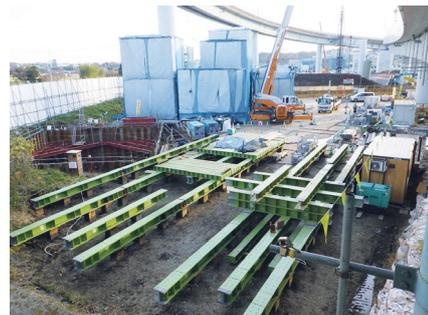
写真三 杭基礎形式クレーン構台
