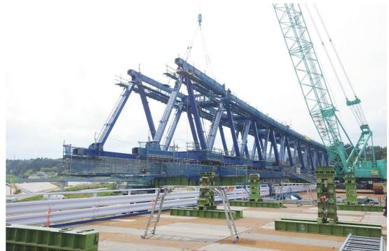
写真-6 3P-4P間 トラス桁架設
