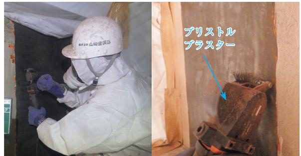
写真-2 塗膜剥離作業状況
