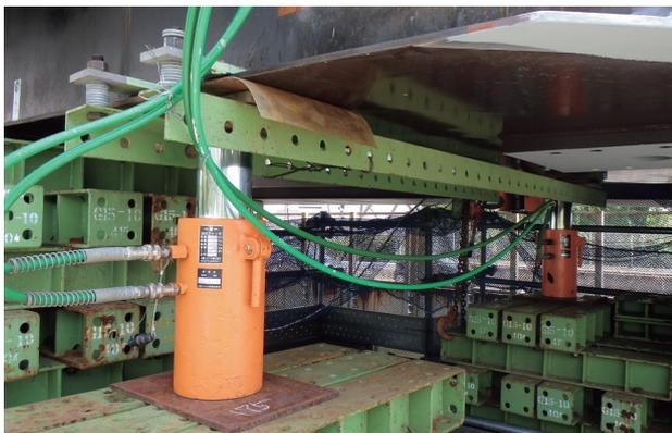
写真-16 桁降下ジャッキ
