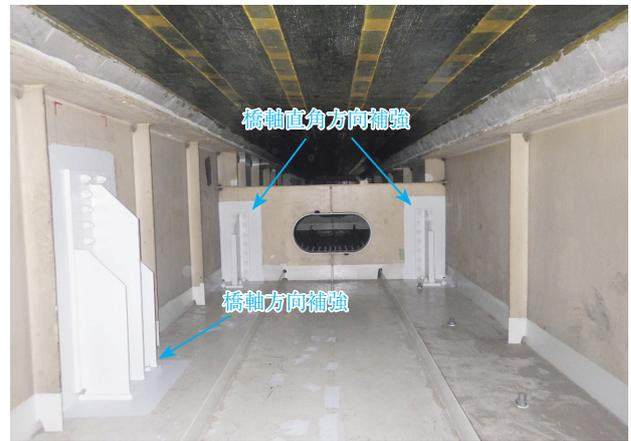
写真-13 補強部材設置完了（箱桁部内面）
