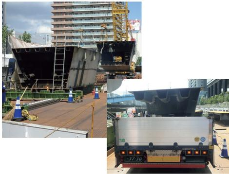
写真-4 鋼桁切断・搬出
