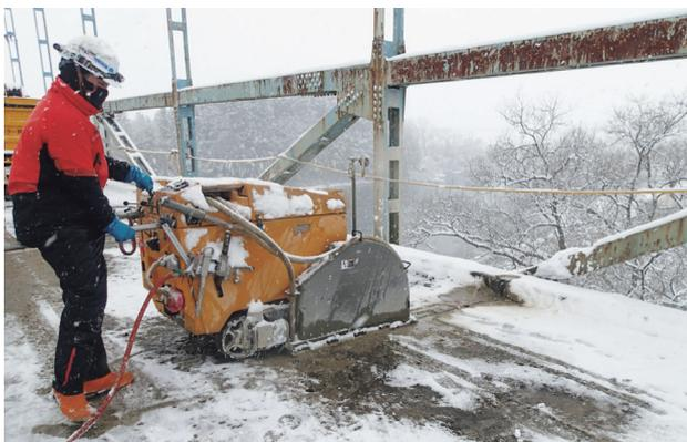
写真-3 床版カッター切断状況
