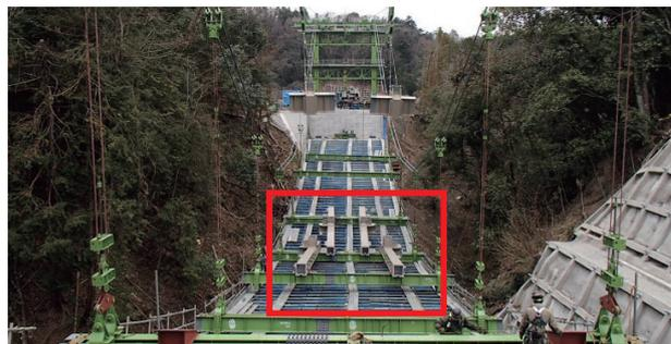
図-19 桁先行架設
