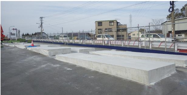
写真-5 鉄筋コンクリート基礎
