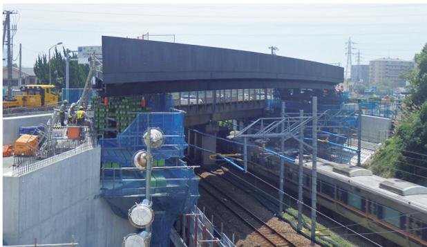
写真-15 桁降下全景
