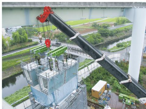
写真-7 ランプ下鋼桁架設状況
