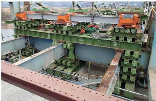
写真-5 引き戻し設備
