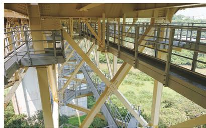
福地川橋上部工検査路 (トラス橋への設置)
