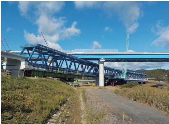
写真-17 架設完了
