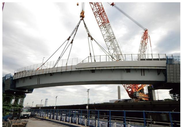
写真-7 大ブロック撤去1日目完了 (陸側)
