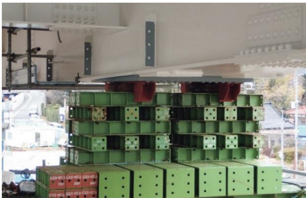
写真-6 架設桁の滑動防止設備
