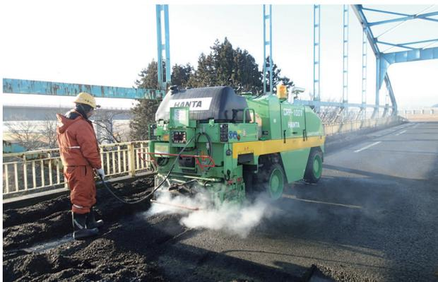
写真-2 アスファルト舗装撤去状況
