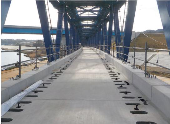
写真-16 プレキャスト床版設置完了
