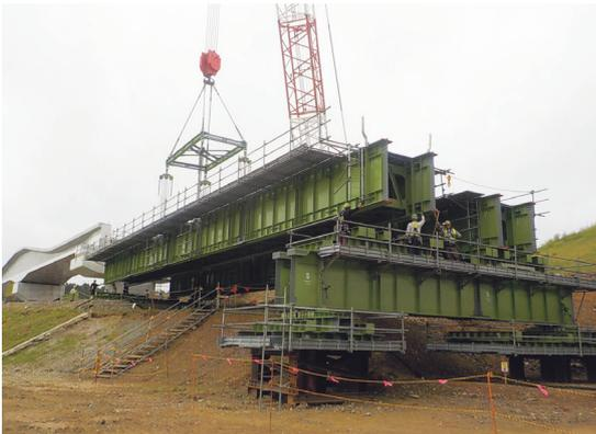
写真-8 2P-3P間ベント設備・軌条設備
