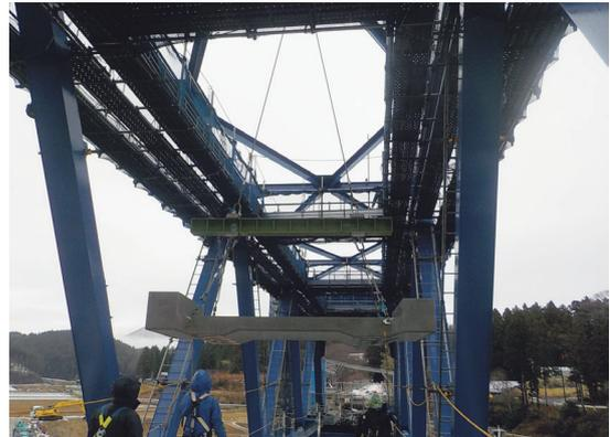
写真-14 プレキャスト床版クレーン架設状況
