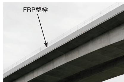
高倉川橋（PC上部工の埋設型枠への適用）
