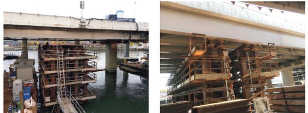
写真-1 支持杭打設状況
