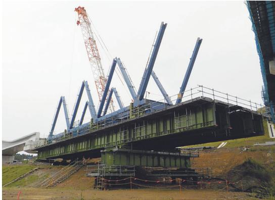
写真-10 2P-3P間トラス桁組立状況
