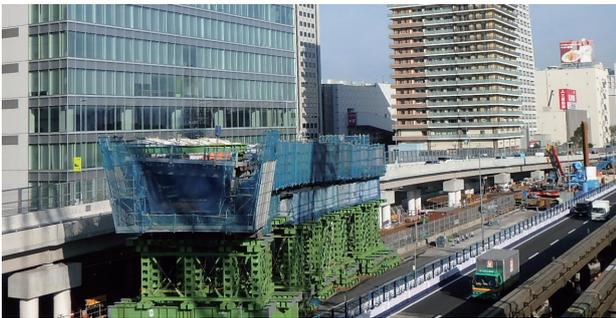
写真-5 ベント設備 (既設上り線)
