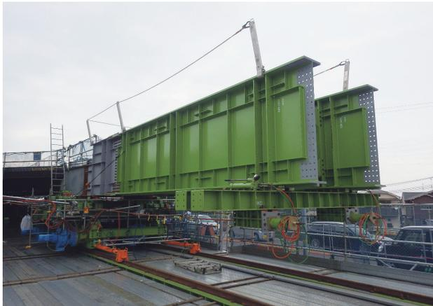
写真-12 台車と後方桁とを拘束
