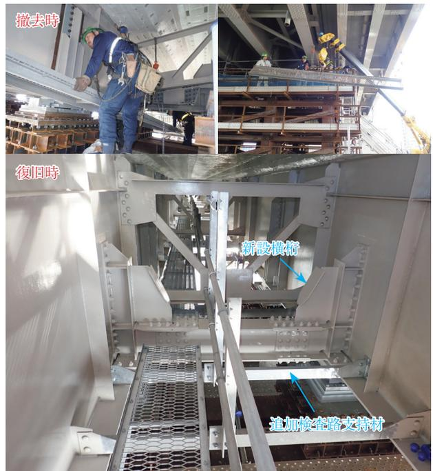
写真-10 検査路撤去復旧状況
