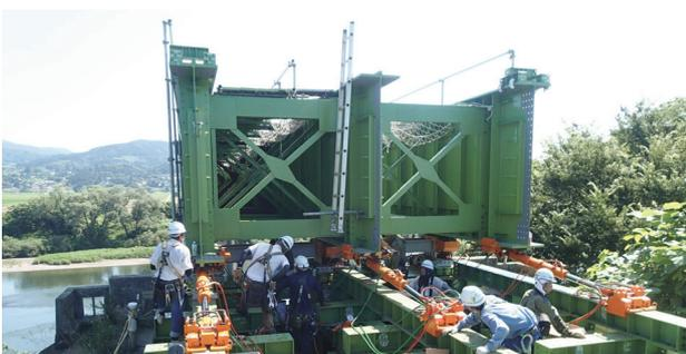
写真-15 架設桁引き戻し状況
