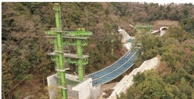
図-17 ケーブル設備完了
