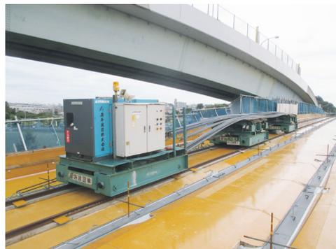
写真-12 運搬台車使用状況
