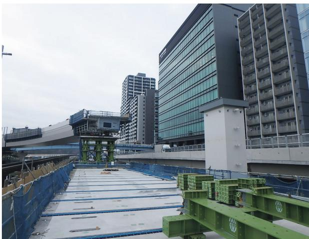
写真-17 大ブロック架設完了
