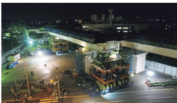
写真-4 縦送り作業中 (STEP-1)
