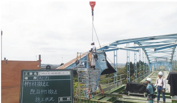
写真-10 ガス切断状況
