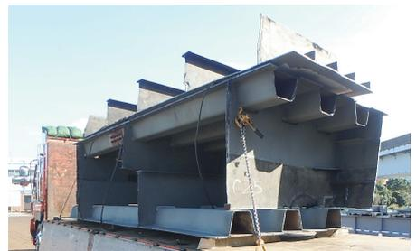
写真-9 鋼桁撤去
