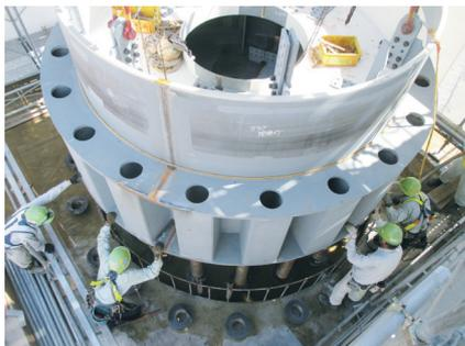
写真一 基部ブロック架設状況
