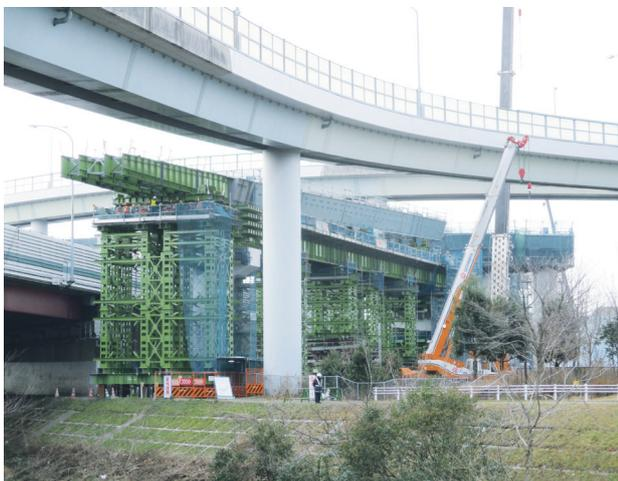
写真-9 B01到達後桁地組状況
