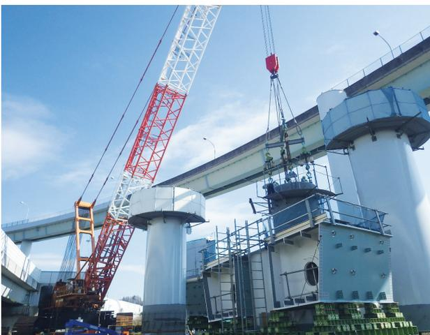
写真-5 柱基部ブロック試験吊り状況
