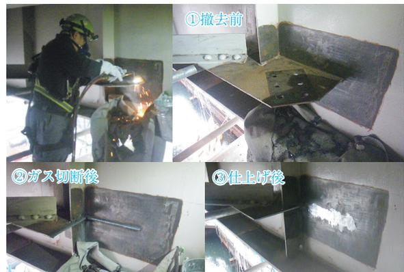
写真-3 既設ガセット撤去状況
