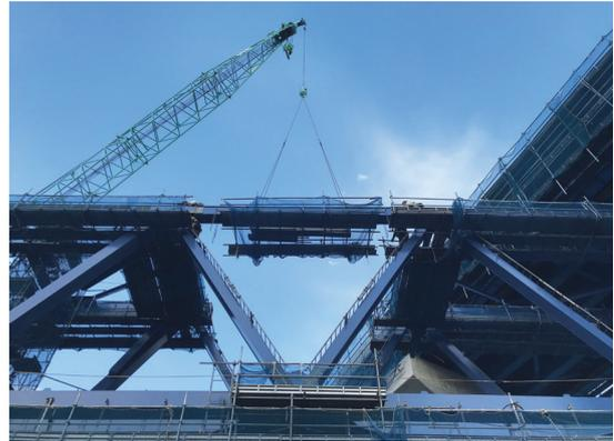
写真-13 上弦材閉合ブロック架設状況
