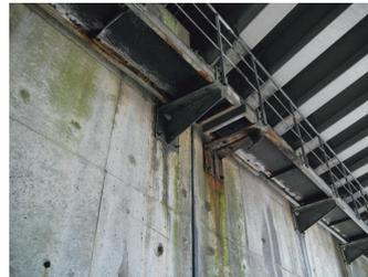
鋼製検査路の腐食による損傷の例
