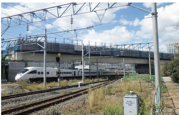
写真-12 桁降下完了 (JR上状況)
