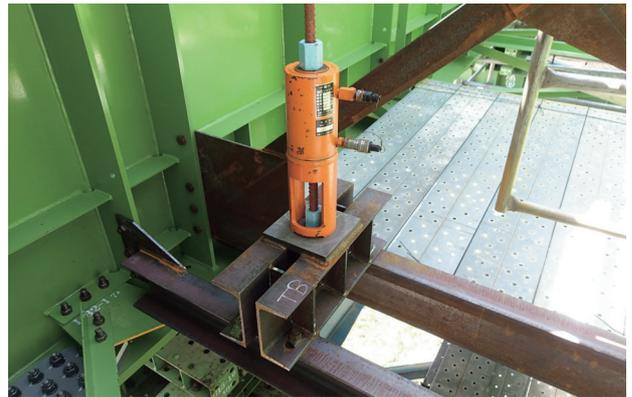
写真-9 吊り下げ設備
