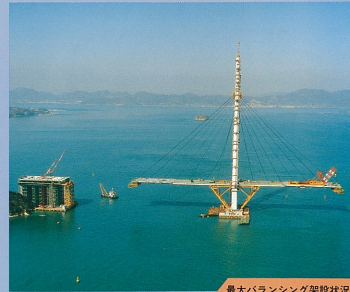
最大バランシング架設状況
