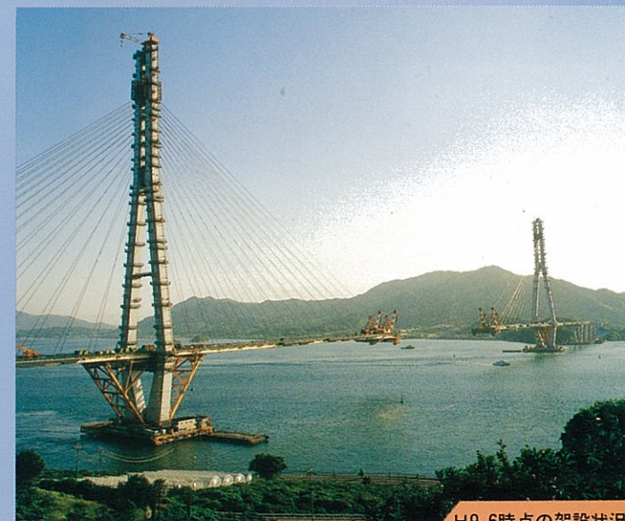
H9.6時点の架設状況
