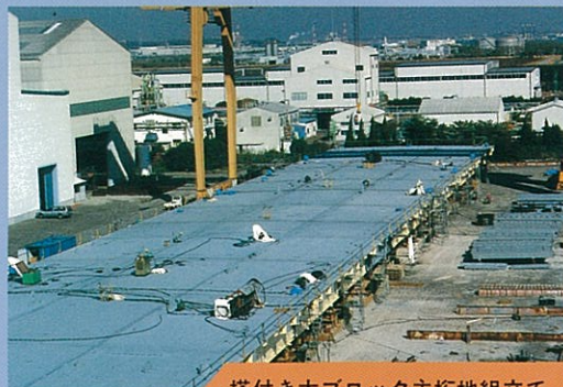
塔付き大ブロック主桁地組立て
