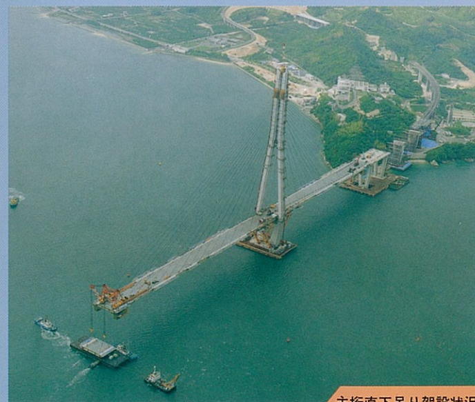
主桁直下吊り架設状況
