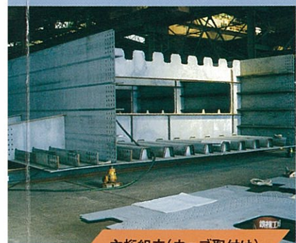
主桁組立(ウェブ取付け)
