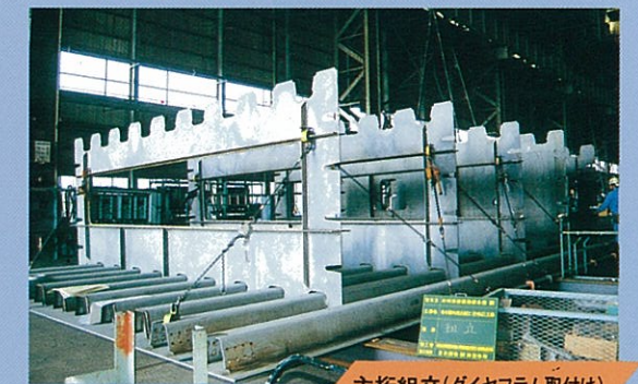
主桁組立(ダイヤフラム取付け)
