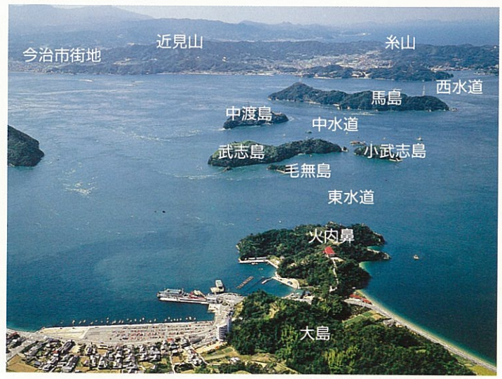
大島上空より架橋地点を望む
